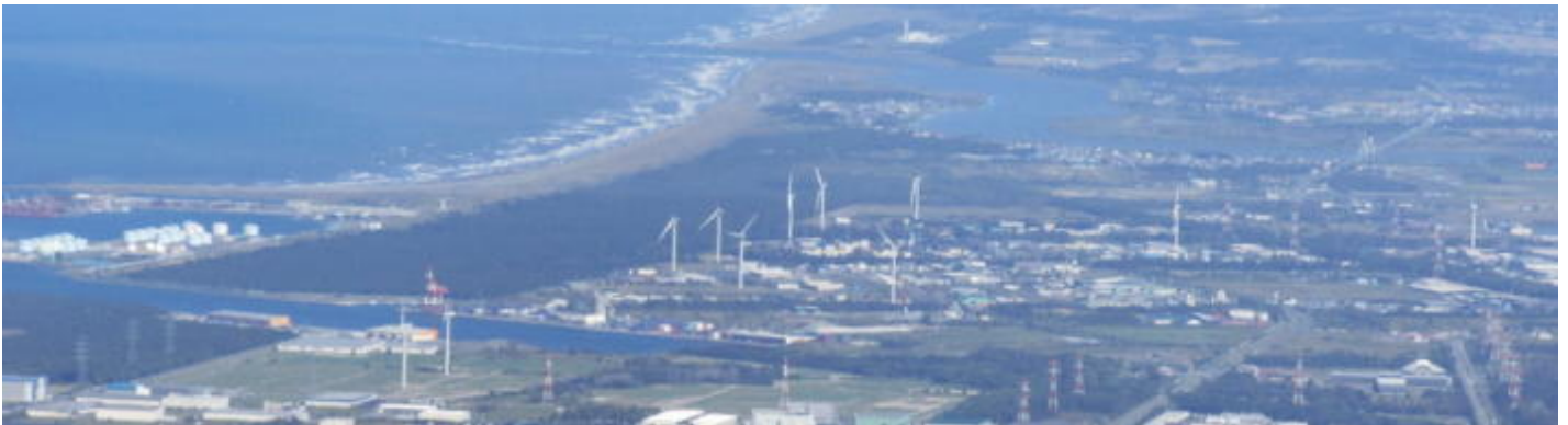
石狩湾岸に建設されている風車群-手稲山からの眺望
